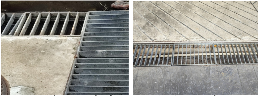
ภาพที่ 5-14 รางระบายน้ำ ติดตั้งตะแกรงดักขยะไว้เพิ่มเติมที่ปลายท่อ บ่อพักน้ำ
