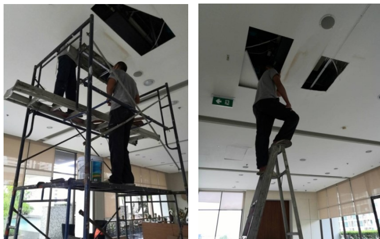
ภาพที่ 5-32 ทำความสะอาดเครื่องปรับอากาศภายในอาคาร
