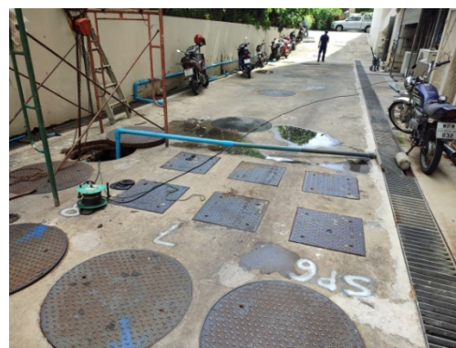
ภาพที่ 5-33 เก็บขยะที่อุดตันรางระบายน้ำ และทำความสะอาดรางระบายน้ำ
