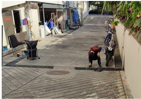
ภาพที่ 5-33 เก็บขยะที่อุดตันรางระบายน้ำ และทำความสะอาดรางระบายน้ำ
